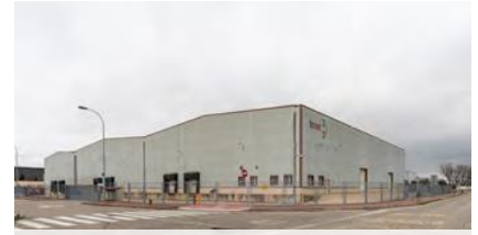
Azuqueca de Henares – Spain
